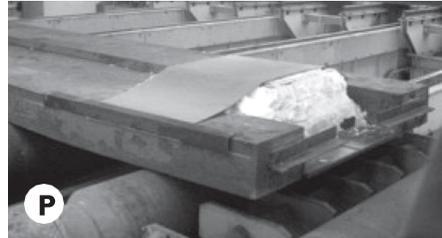
Wenn sich die Isolierung durch die Ofentürdichtungen verschieben könnte, bringen Sie ein Blech über dem System an und sichern Sie dieses mit einem Winkeleisen, das an die Vorderkante der Platte (P) geschweißt wird.
