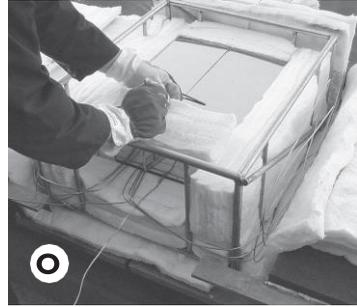
Falten Sie die äußere Fasermatte um die Seiten und die Oberseite der Barrierebaugruppe und schneiden Sie ein weiteres Stück der Matte zu, das senkrecht an der Vorderseite des Dämmrahmens anliegt. Das Ziel ist es, so viel Fasermattenisolation wie möglich um die gesamte Barriere herum zu erhalten, und dies kann das Schneiden kleiner Stücke erfordern, die in den Plattenausschnitt gesteckt werden.
